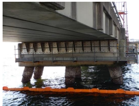
ステンレス鋼構造物エンジニアリング事例 落橋防止ブラケット
