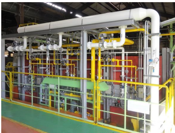
水素燃焼実証試験を行う鋼材熱処理炉
