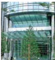
玄関庇・カーテンウォール
