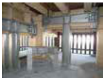
木造の五重塔の耐震補強
