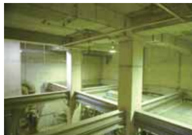
完工後 耐震補強された建物内部
