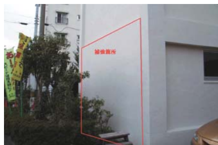
白扇索耐震補強
